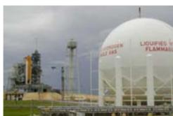
Stockage d'H<sub>2</sub> liquide de la NASA à -253°C
