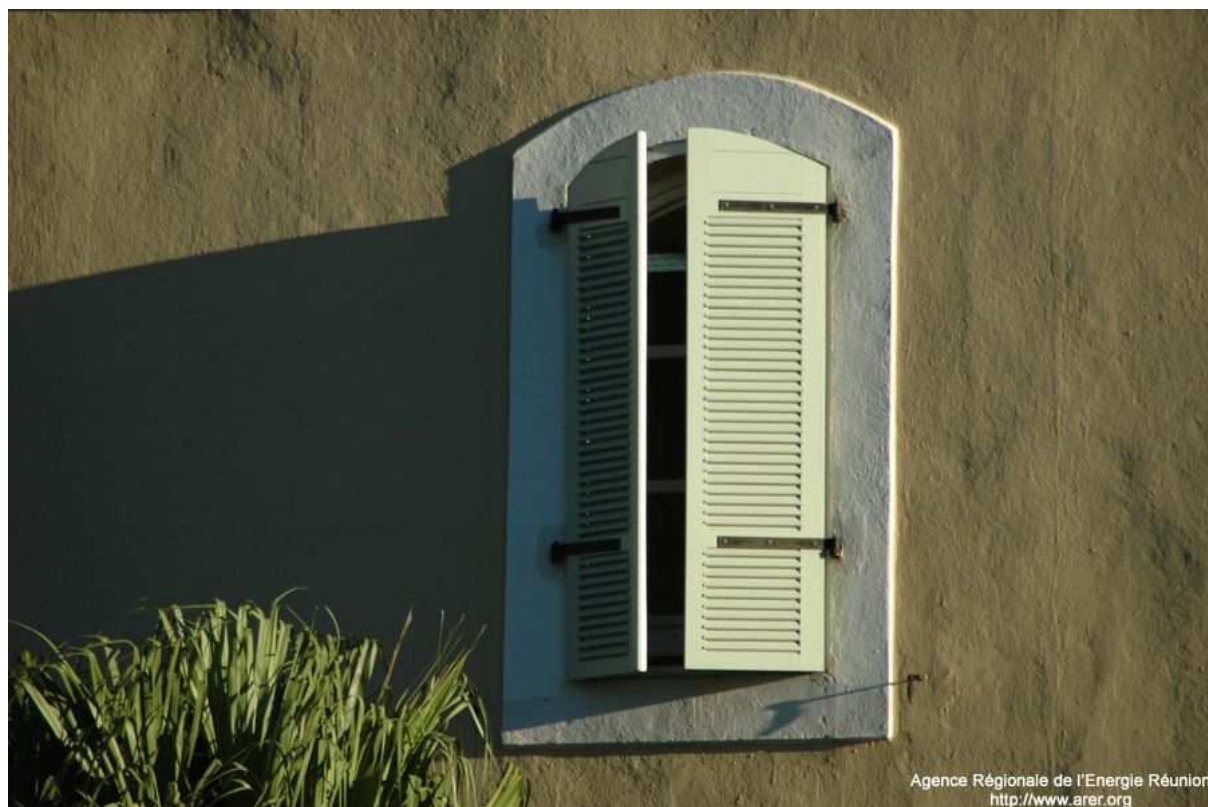
Figure 36 : volets persiennés avec système de blocage à 45°, conforme à PERENE et RTAA DOM quelque soit l'orientation – Nota Bene : pour être conforme à la RTAA DOM, au moins 20% de porosité.
