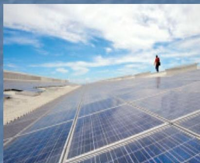
Ce record a été battu en 2008, avec la centrale SITAR à Saint Pierre. Les 7930 modules Photowatt, recouvrant 13 000 m<sup>2</sup> de toits offrent une puissance de 1,310 MWc
