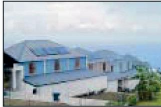
Le chauffe-eau solaire (CES), de plus en plus courant sur nos toitures réunionnaises, est un dispositif permettant de chauffer l'eau sanitaire à l'aide du rayonnement solaire.
