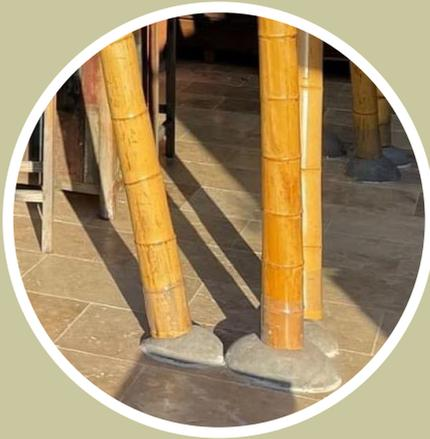
**Bambou Bar** en MOSO bambou. Fondations en basalte péi, faux plafond en **panneaux de ravenal**, couverture **tôle ondulée**. Planche de rives en **pin**.
