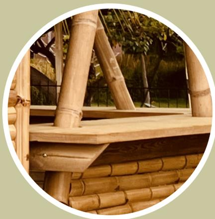
**Bambou Asper** pour structure de Carbet cuisine. Faux plafond en **Bambou Guadua**, couverture **tôle ondulée**. Planche de rives en **pin**. Planche de bar en **Mauvinguy**.
