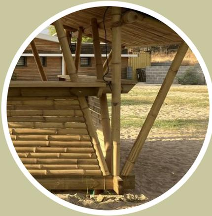
**Bambou Asper** pour structure de Carbet bar. Faux plafond en **Bambou Guadua**, couverture **tôle ondulée**. Planche de rives en **pin**. Planche de bar en **Mauvinguy**. Bamboo training session. Conception étudiants école d'architecture du port, réalisation prototype Workshop ENSAM 2022. Démontage, remontage et confortement lors d'une formation B.à BA. structure bambou
