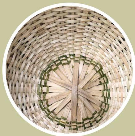
Prototype ombrière **bambou**, résiste aux **vent très forts**. Passer d'une ombrière agricole **100%** acier et plastique **importés**, à une serre composée à **99%** de matériaux **biosourcés** (1%tige filetée), **bambous** tressage panier, roches **basalte** du site en fondation. **Zéro** béton. **Zéro** déchet. Vers une **résilience** du monde **agricole**.
