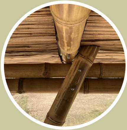
Varangue en **ossature** Bambou **Asper**, faux plafond en panneaux de **Ravenal** et toiture en **tôle ondulée**.
