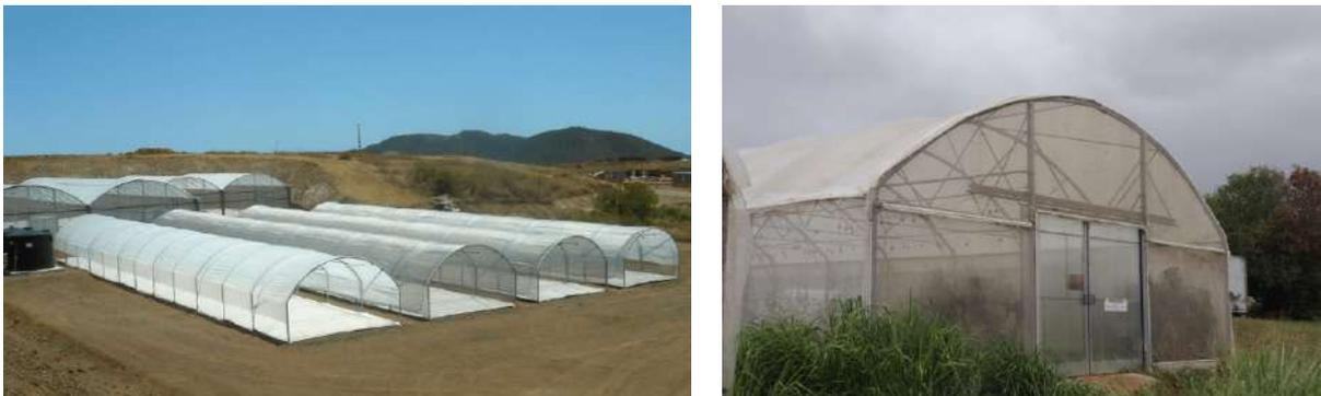
Figure 35 : serres tunnel avec pieds droits, revêtement bâche plastique (à gauche : Agrilogic systems) et filet *insectproof* (à droite : exploitation Jean Vidal, Fleurimont, credit personnel)
