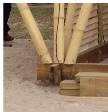
*Avantage* : complètement démontable, facilement déplaçable et remontable car toute la structure est réglée sur le solivage, attention à la hauteur des plugs bois pour permettre l'emboîtement des tripodes préfabriqués au sol
