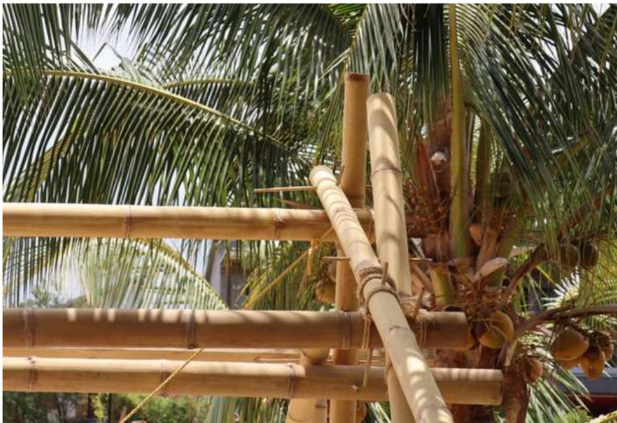
*Avantage* : assemblage 100% biosourcé, pas de risque de corrosion (pas d'éléments métalliques)
