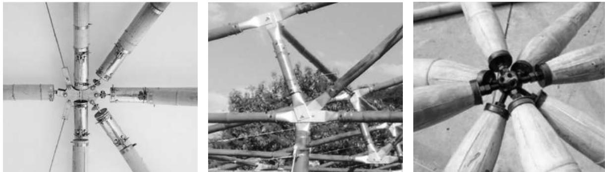
Figure 27 : Assemblages par connecteurs métalliques (photos Building with Bamboo, Gernot Minke)
