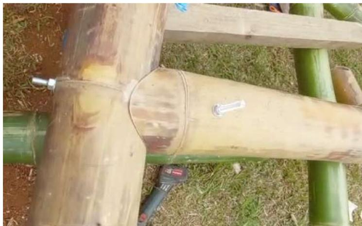
*Avantage* : assemblage dans un plan, économie de matière, robuste à l'arrachement, bon transfert des charges verticales
