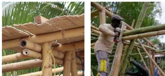
*Avantage* : rapide et simple à mettre œuvre, facilité de démontage/remontage, beaucoup de guides de bonnes pratiques sur ce type d'assemblage
