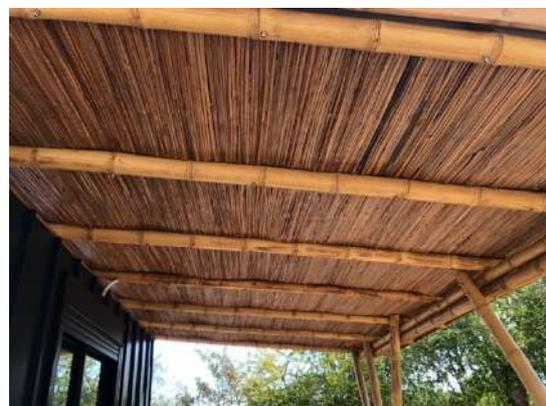
Figure 65 : Exemple de toiture étanchée, faux plafond isolant en panneaux de ravenala (à droite), en mats (à gauche), Hôtel Dina Morgabine, Saint Gilles les Bains (crédit personnel)
