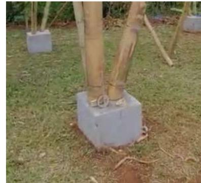
*Avantage* : ajustement de l'angle des poteaux inclinés sur chantier par torsion des tiges, toute la trame y compris les tripodes peuvent être montés au sol avant levage de la ferme, double système de résistance à l'arrachement, possibilité de préfabriquer les plots béton en y intégrant les tiges métalliques d'ancrage, pas d'utilisation de scellement chimique
